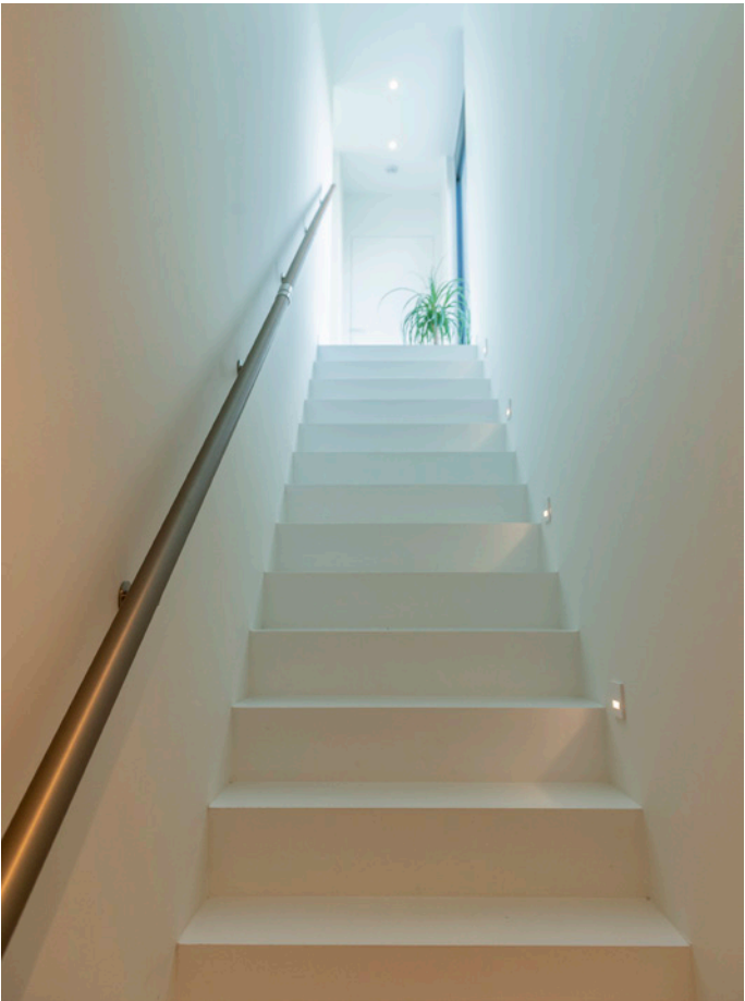
De trap werd door Steppa Kunststofvloeren met polyurethaan bekleed.
