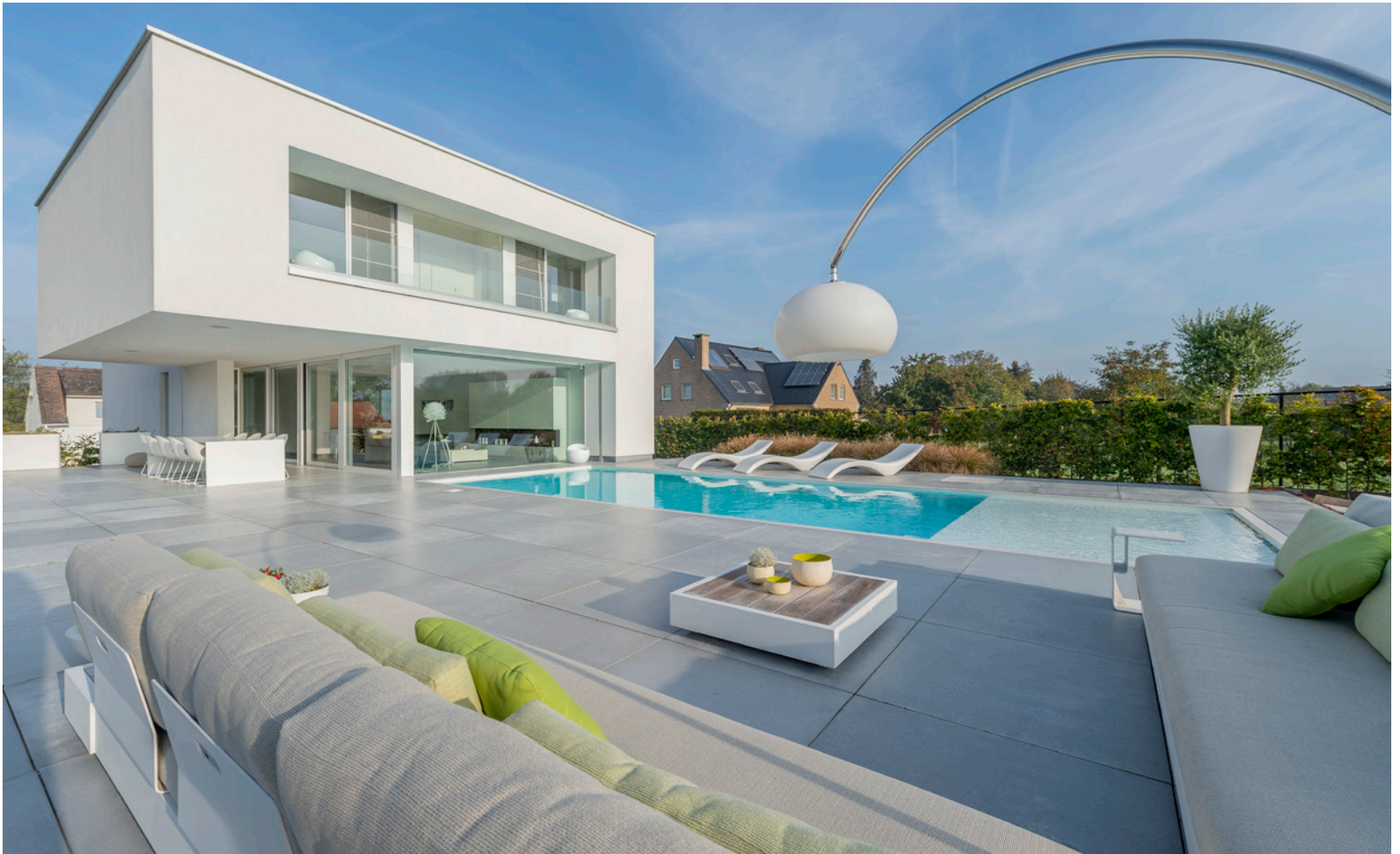
Met het meubilair van Meubili is het heerlijk chillen of zonnen aan het zwembad. Het dakwerk van de woning werd gedaan door Servranckx uit Aspelare. De pleisterwerken werden gerealiseerd door Gevelbepleistering - Pleisterwerken MEERT bvba.
