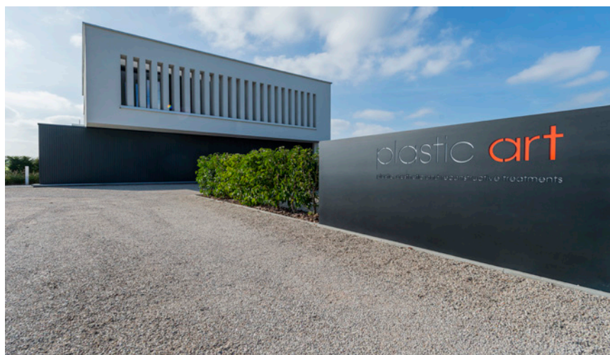
Ook bij dit project was het Servranckx die de dakwerken verzorgde en was de hoofdaannemer Hemerijckx P&A Algemene Bouwonderneming BVBA.
