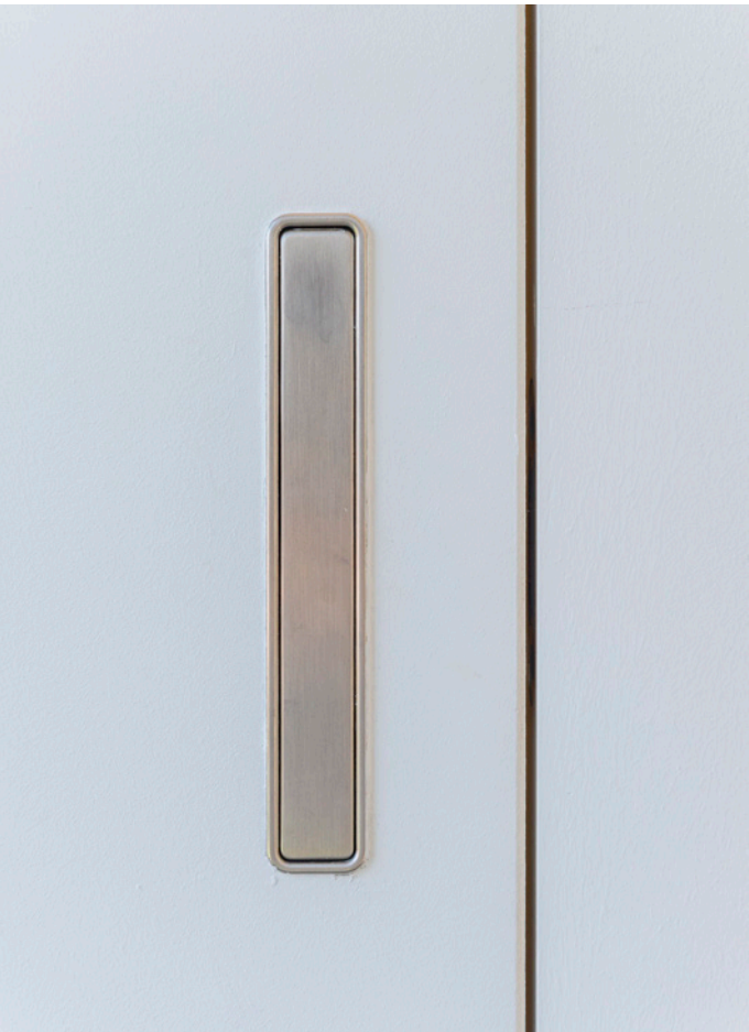
Detha Doors leverde de vlakwandige Xinnix deursystemen met verborgen scharnieren, magneetsluitingen en dichtingsrubbers. Er werd gebruik gemaakt van een magnetisch xrolsysteem XA-NZ© om een vlakwandig ingewerkte deurtrekker type XA-H160 te kunnen integreren.
